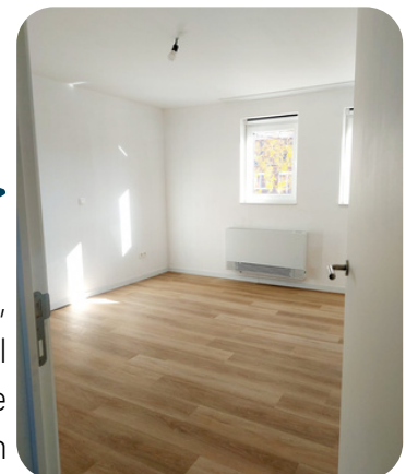
Sint-Luciestraat, Rijkevorsel totaalrenovatie van twee woningen
